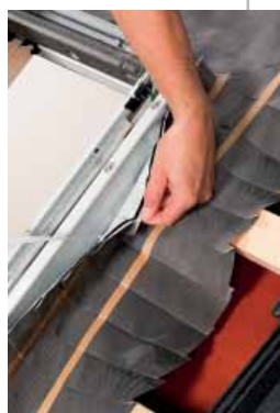
Alátétfólia vízelvezető csatornával
